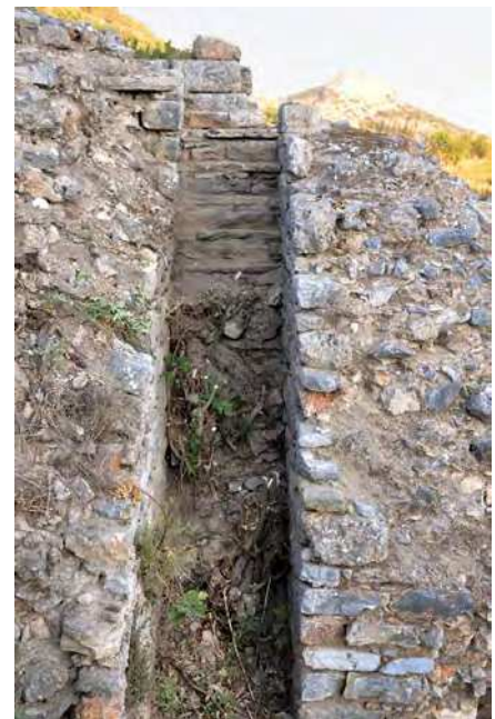
Ephesos, Serapeion. Schäden an der Bausub- stanz durch biogenen Bewuchs: Bäume am Treppenaufgang (Foto M. Pliessnig)
