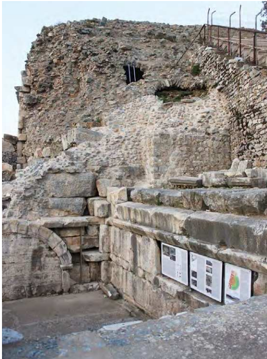
Ephesos, Großes Theater. Stützkonstruktion am Nordeingang mit Informationsstafeln für die Besucher (Foto E. Tekin)
