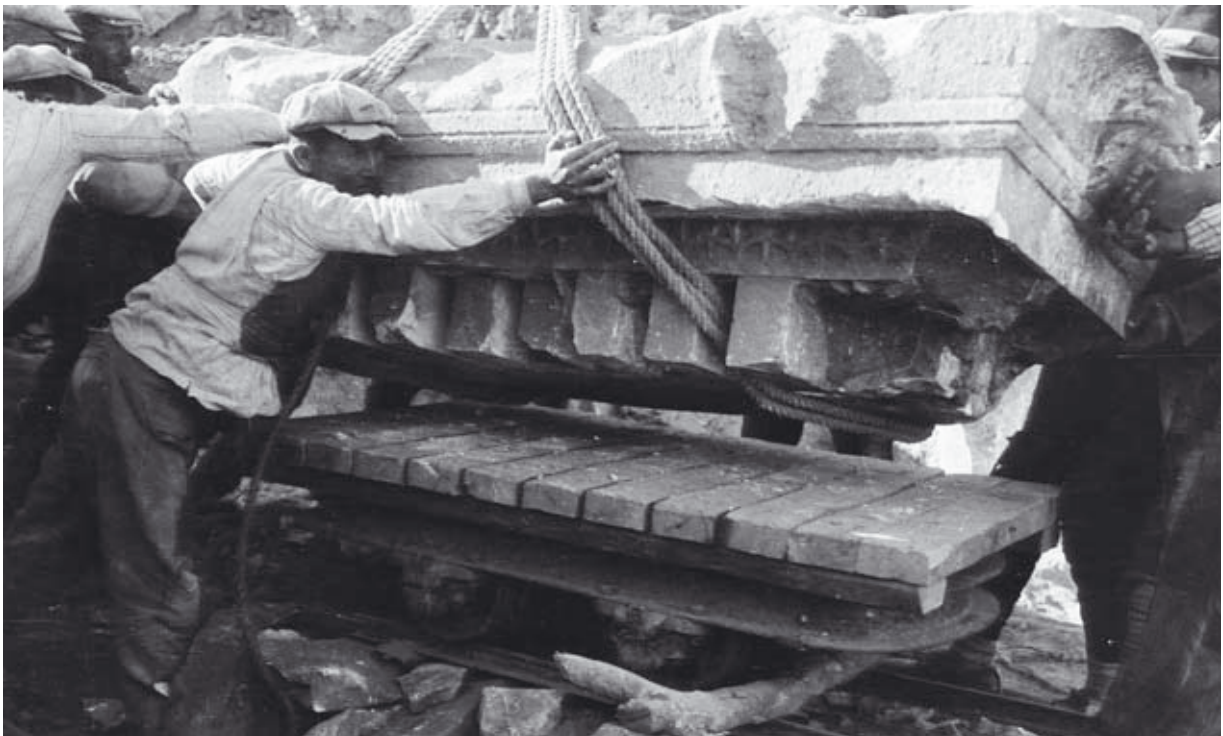
Taf. 13, 2: Abtransport eines Zahnschneiteblockes an der Ostseite (1933)
