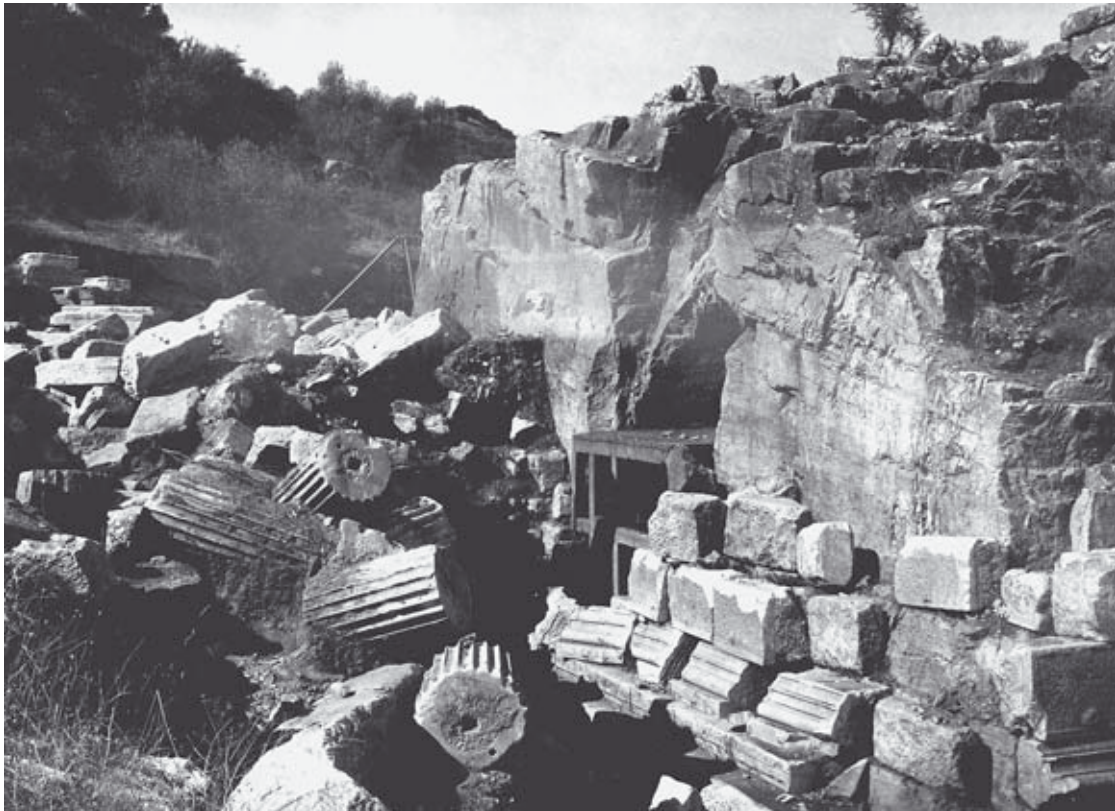
Taf. 19, 1: Südseite mit dem 1934 über der Grabkammer errichteten Schutzbau (1935)
