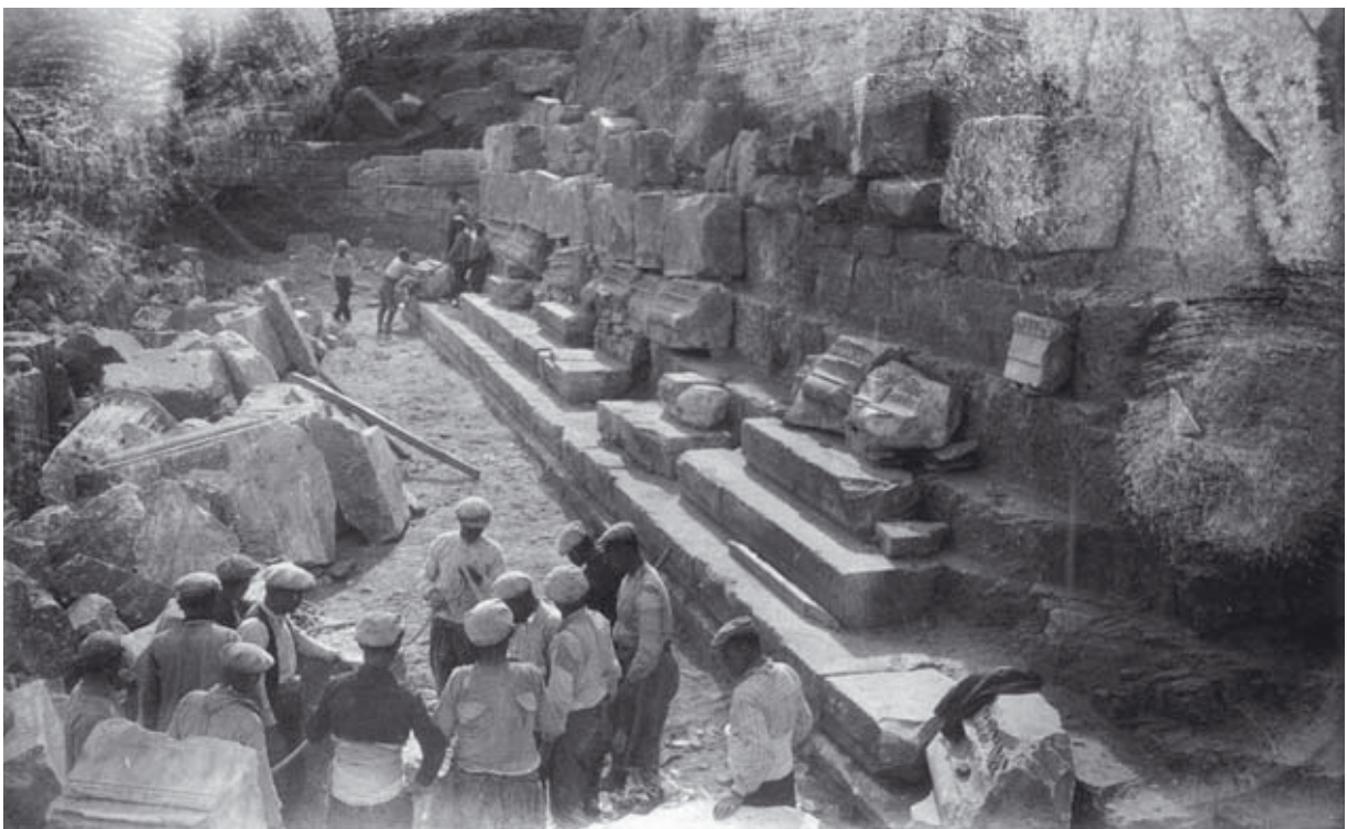
Taf. 14, 2: Vollständig freigelegter Stufenunterbau der Ostseite (1933)
