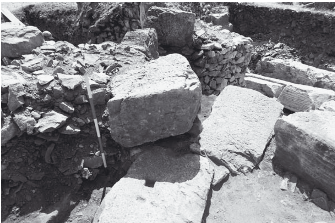
Taf. 36, 2: Weitere Blöcke des originären Ringes zur Stabilisierung der Hinterfüllung des Kalkofens während der Freilegung (2002)
