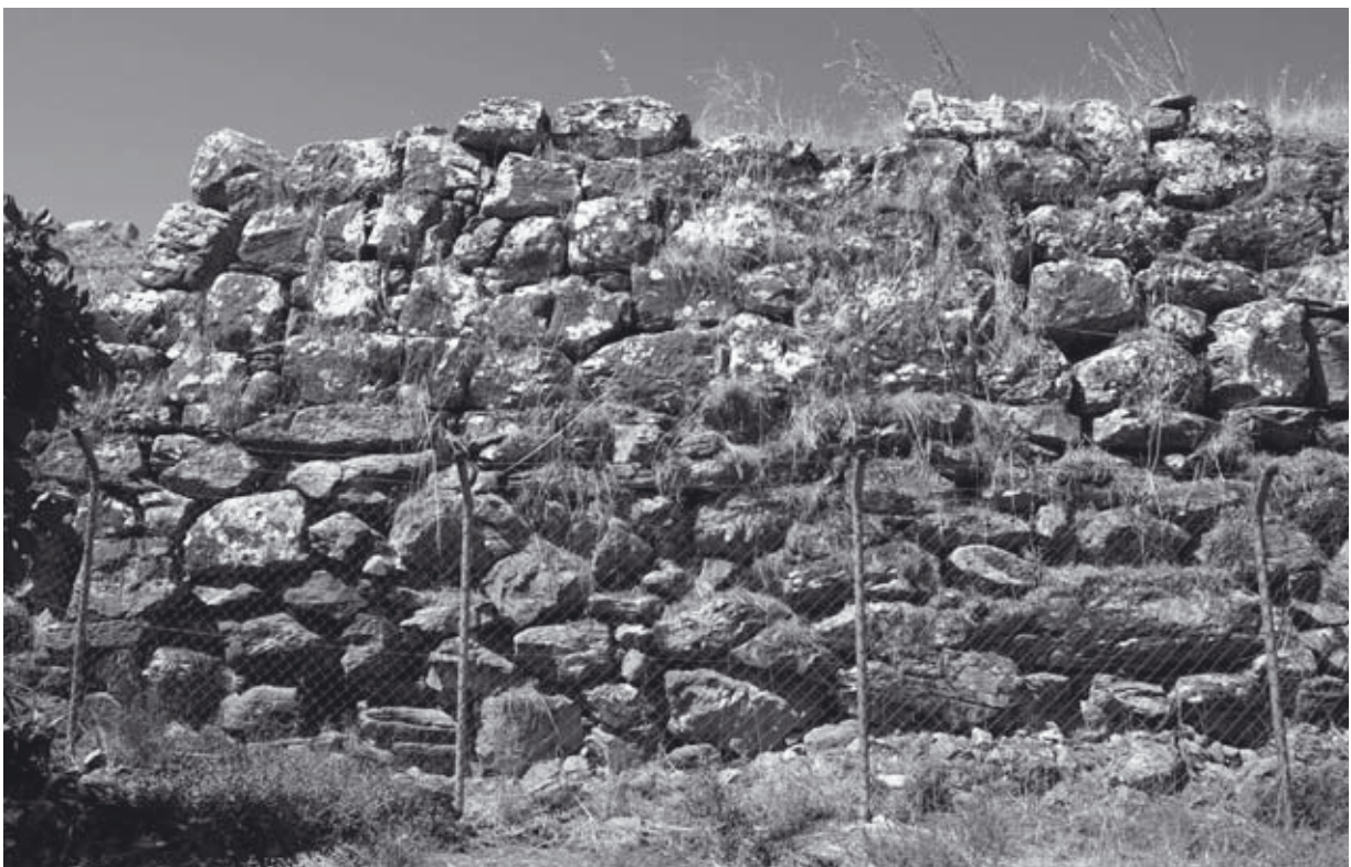
Taf. 28, 2: Terrassenmauer, mittlerer Mauerabschnitt mit Ausgleichslage (2002)
