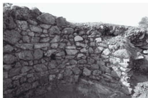
Taf. 34, 5: Südwand des Kalkofens mit Felsstufe (2002)
