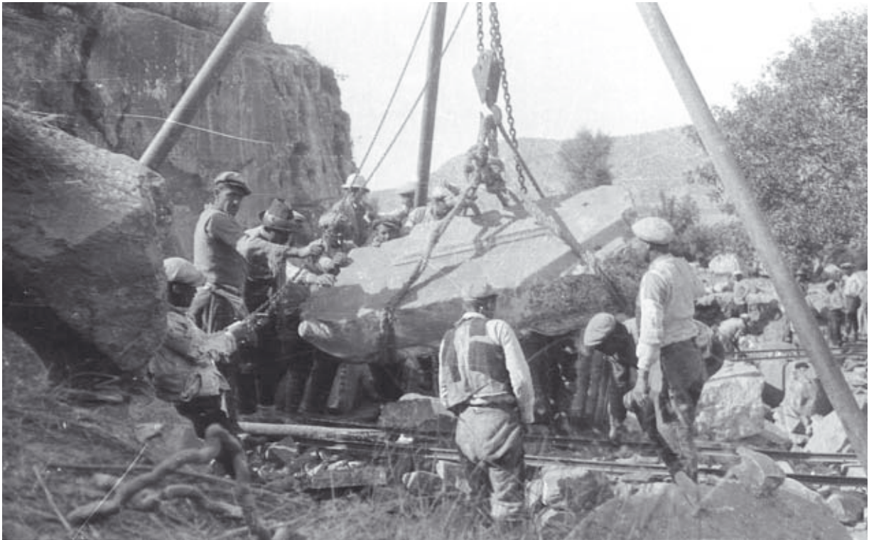
Taf. 13, 1: Abtransport von Architekturböcken an der Ostseite (1933)
