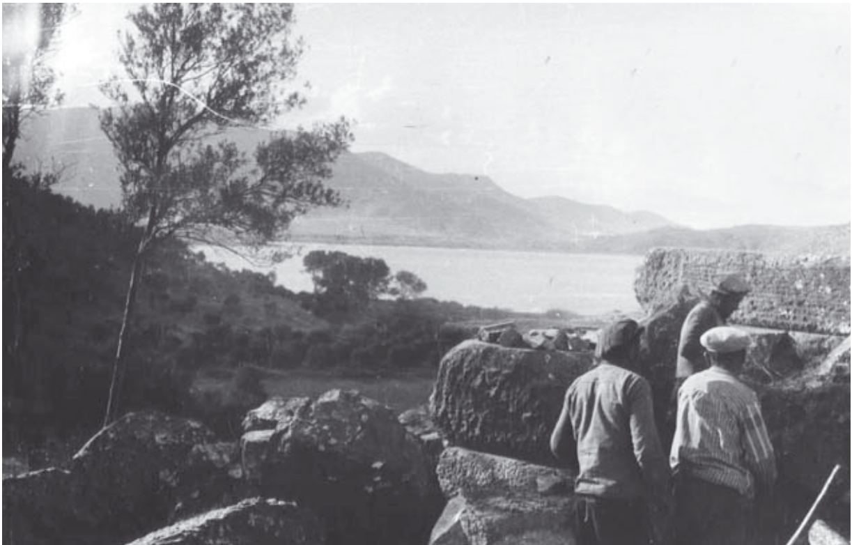
Taf. 5, 2: Arbeiten auf der Oberseite des Sockels 1933, im Hintergrund der temporäre See
