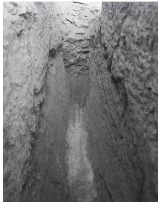
Taf. 32, 4: Südlicher Schrotgraben mit Hinterfüllung während der Freilegung (2001)
