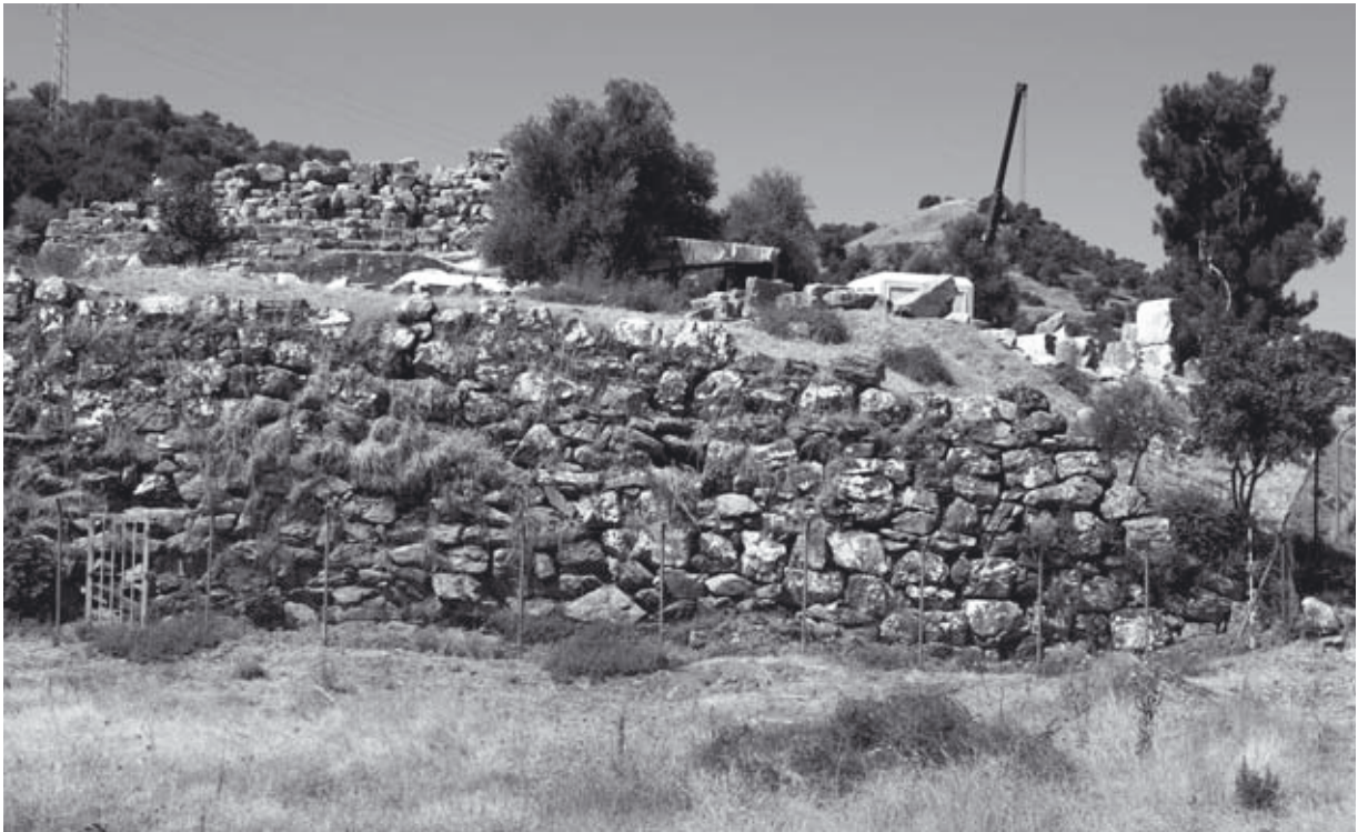
Taf. 28, 1: Nordende der Terrassenmauer (2002)
