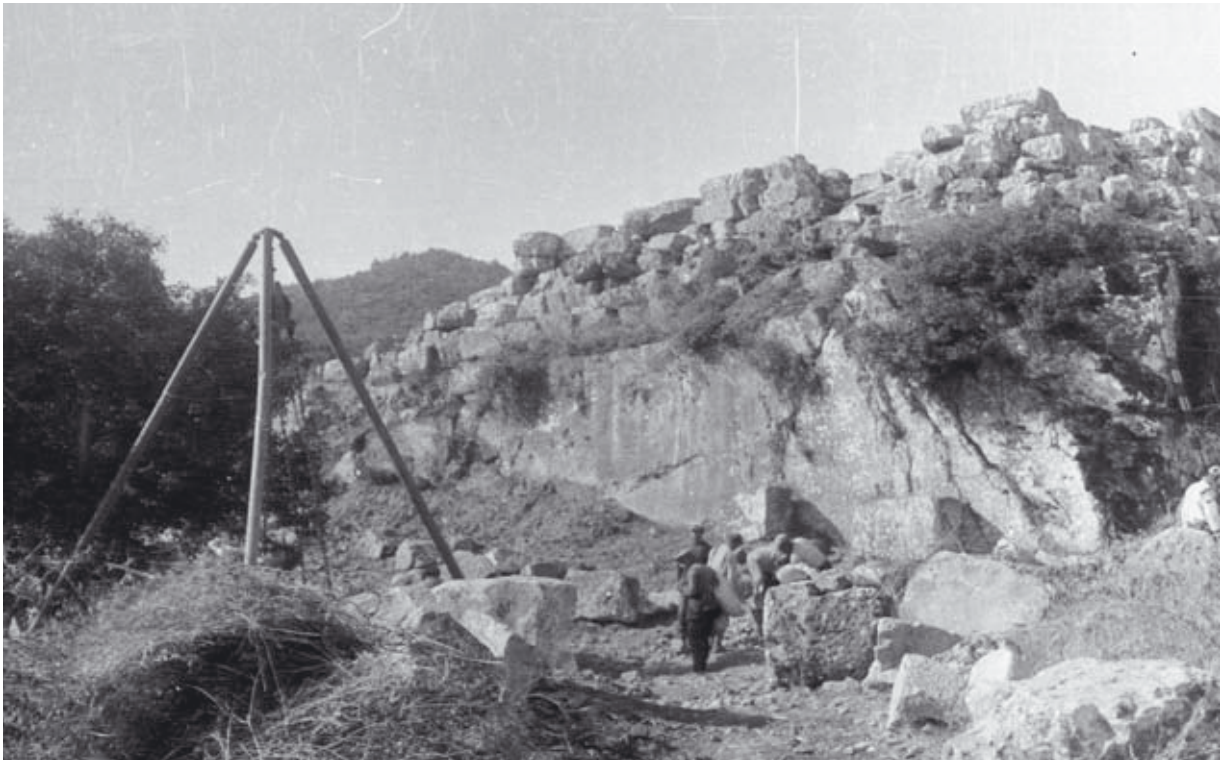
Taf. 12, 1: Ansicht der Ostseite zu Beginn der Freilegungen von Nordosten (1933)
