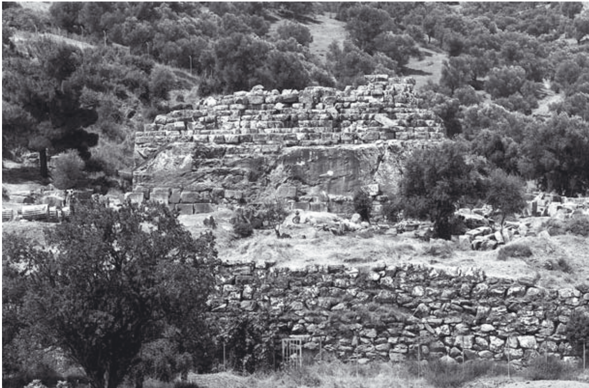
Taf. 9, 1: Terrassenmauer und Mausoleum (2002)
