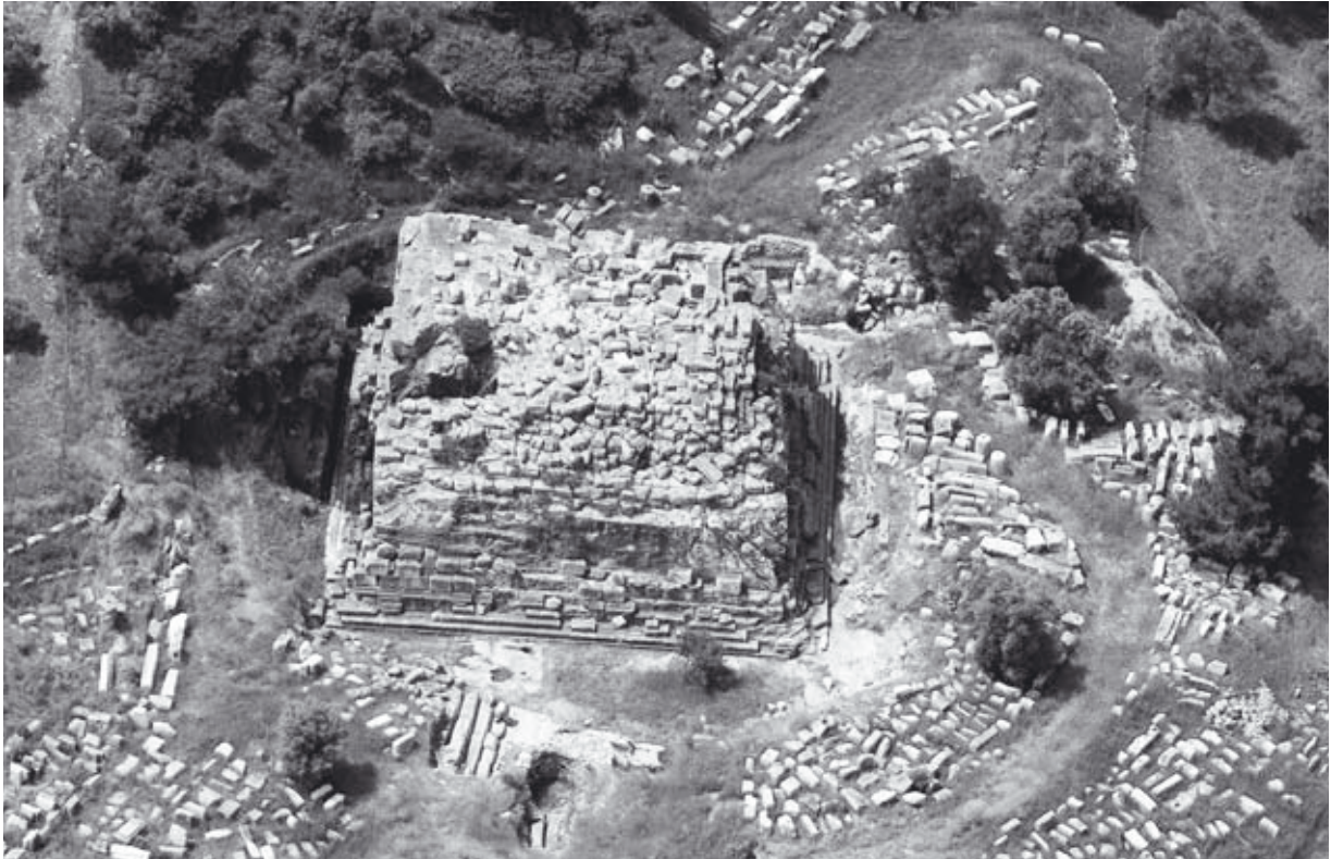
Taf. 5, 1: Blick auf den Sockel, die Abbaufäche und den Kalkofen von Osten
