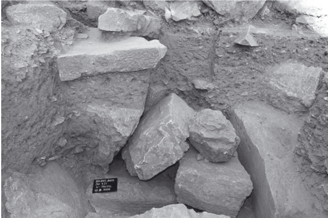
Taf. 54, 1: SO 7, West-Ost ausgerichtete Felsbank (rechts), davor an der Sohle ein weiterer Nord-Süd verlaufender, relativ kurzer Schrotgraben und darüber nicht verwendete Blöcke (2003)
