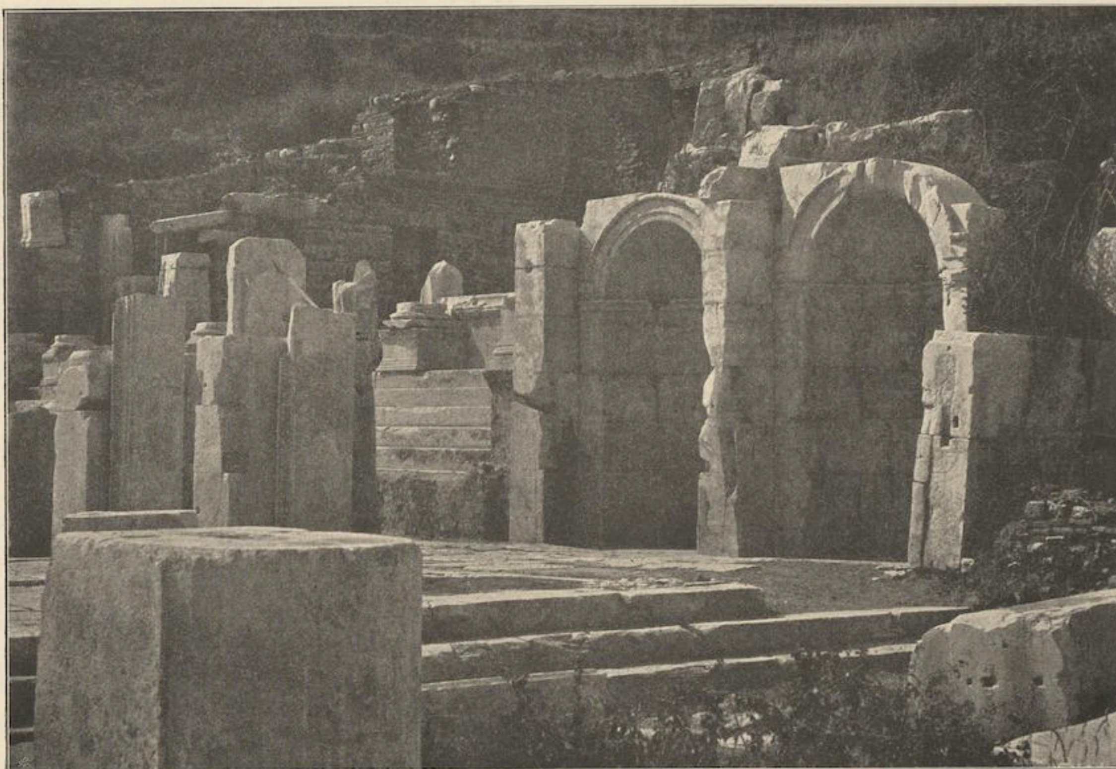
Fig. 68 Westlicher Teil des Südtores von Nordosten.
