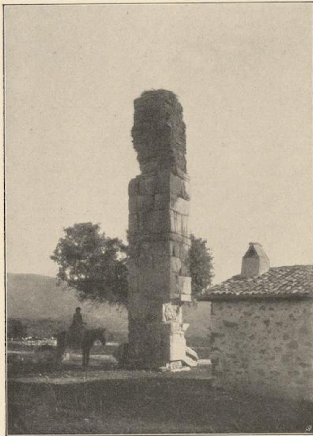
Fig. 247 Pfeiler 102 des Aquäduktes in Ajasoluk.
