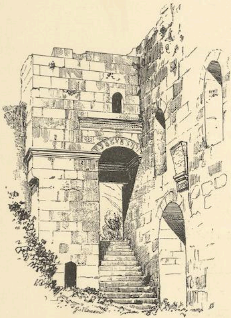
Fig. 32 Aufgang zum Portal in der Südostecke des Hofes.
