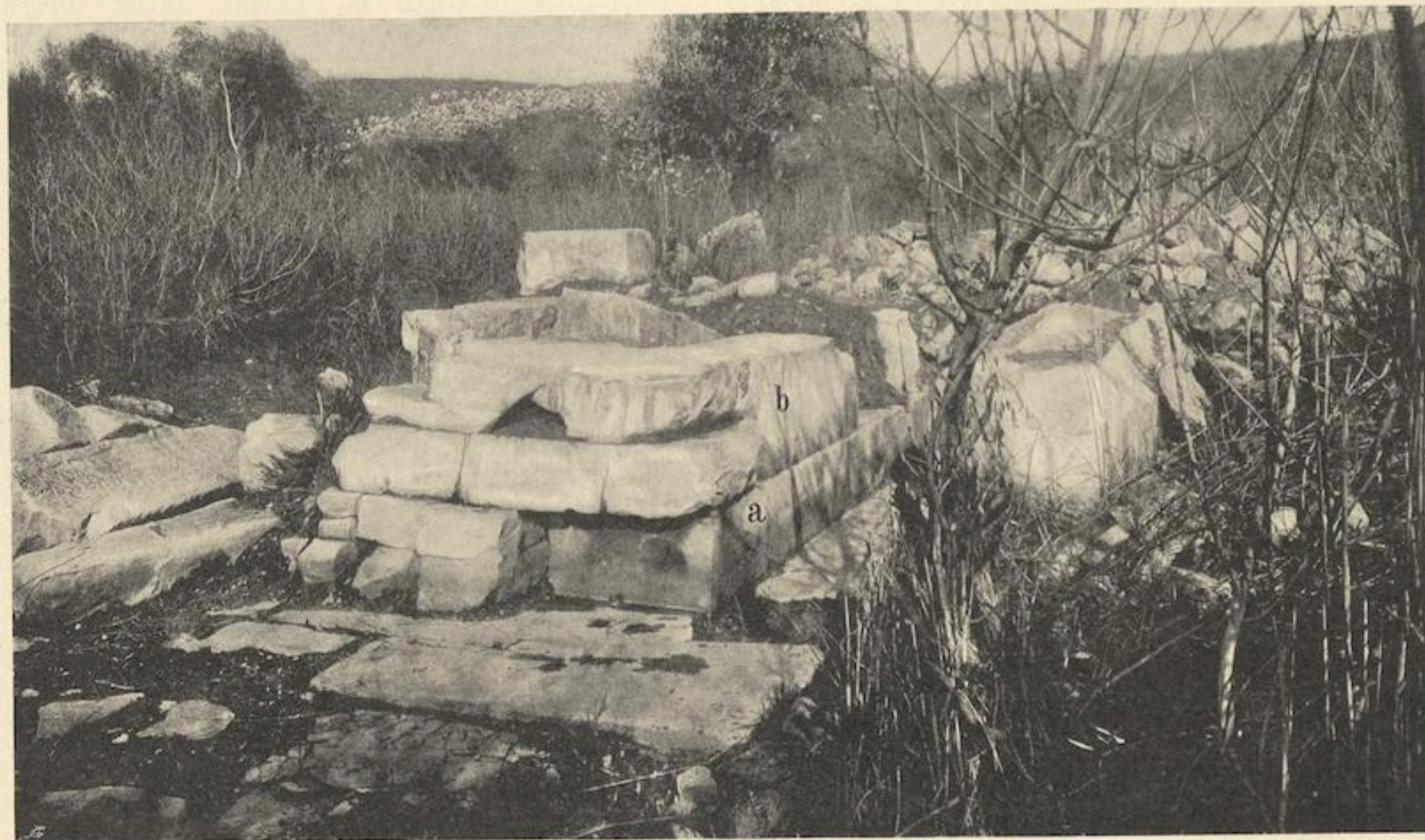
Fig. 191 Ansicht der Türwand G der Tempelcella.
