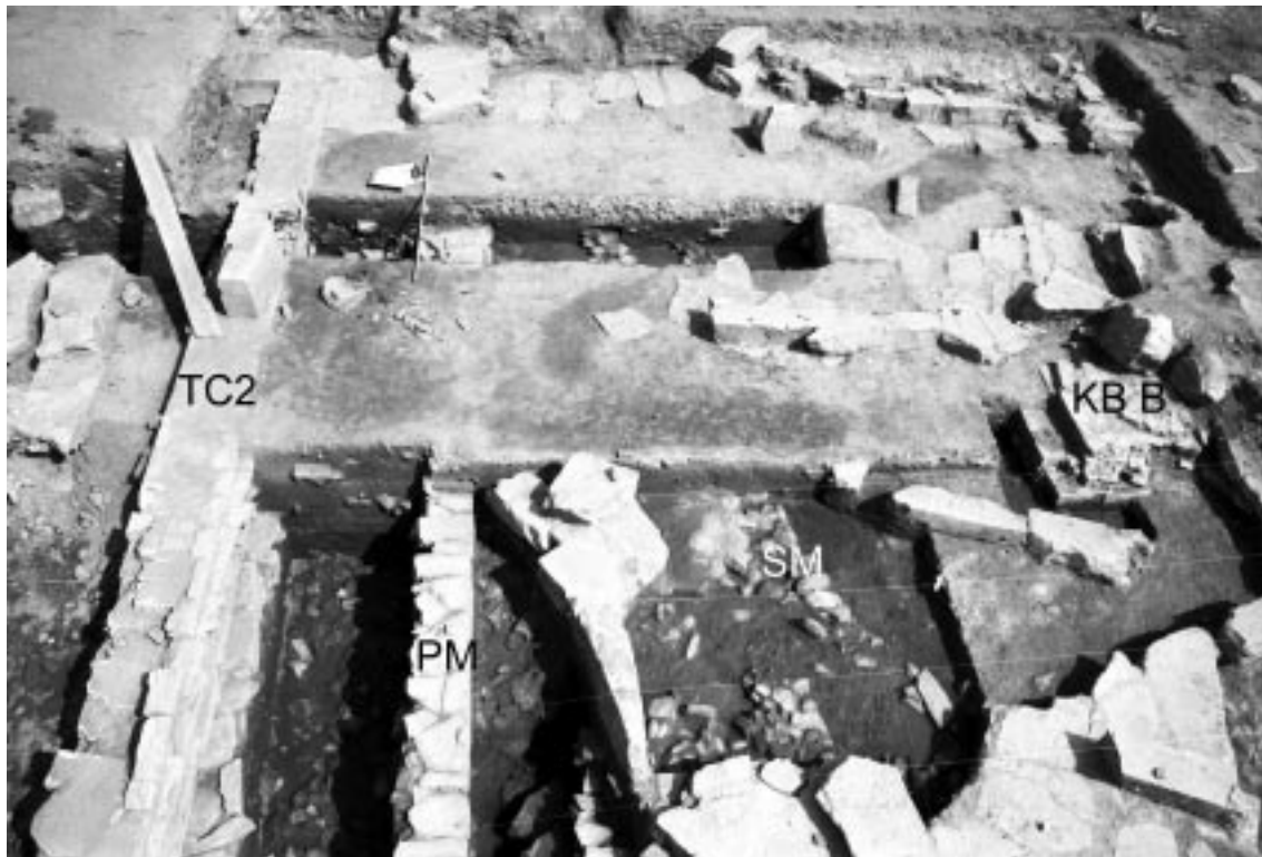
8 Der Grabungsbereich östlich des Tempels C (Blickrichtung nach Norden). Links im Bild liegt die Tempel-C-Ostmauer, rechts davon die Parallelmauer (PM), in der Diagonale die Schräge Mauer (SM), rechts im Bild die Kultbasis B (KB B). Die dunklen Streifen in der oberen Grabungsfläche markieren die radial angelegten Schnitte D. G. Hogarths (1991)
