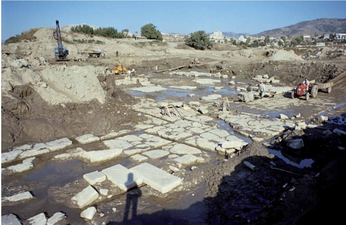
Abb. 6 Ephesos, Artemision. Spätklassischer Hofaltar. Ansicht von Südwesten während der Ausgrabung 1970. Im überschwemmten Kanal der bleiernen Druckwasserleitung, der südlich (rechts) über das Altarfundament hinaus verfolgt wurde, sind die Marmormuffen erkennbar (Foto A. Bammer. © ÖAI Wien)
