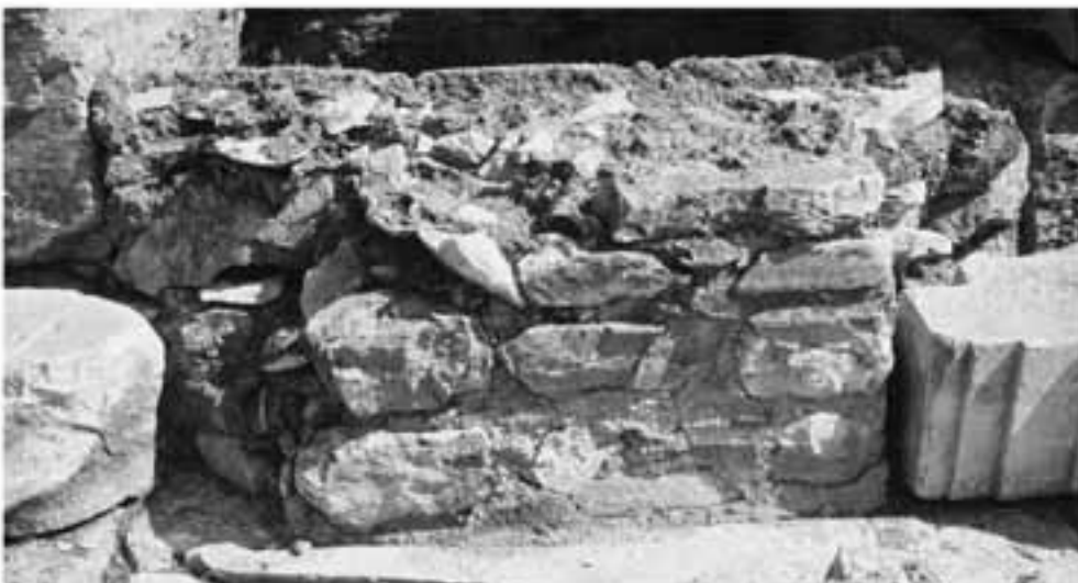
Taf. 20, 3: Interkolumnium 10–11, byz. Abmauerung
