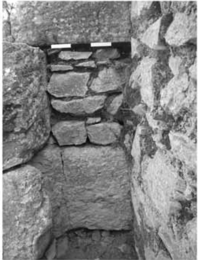
Taf. 13, 2: Pfeiler 1, Bruchsteinmauerwerk zwischen T-Verlängerungen
