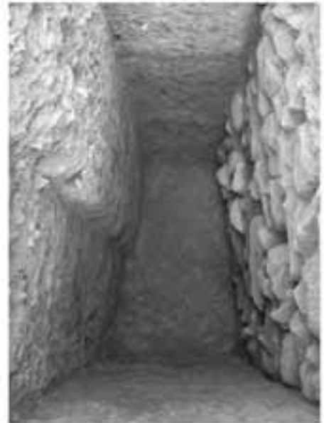
Taf. 37, 3: So 12, Lehm-schicht und Fundamentierung-mauer der Süd-wand
