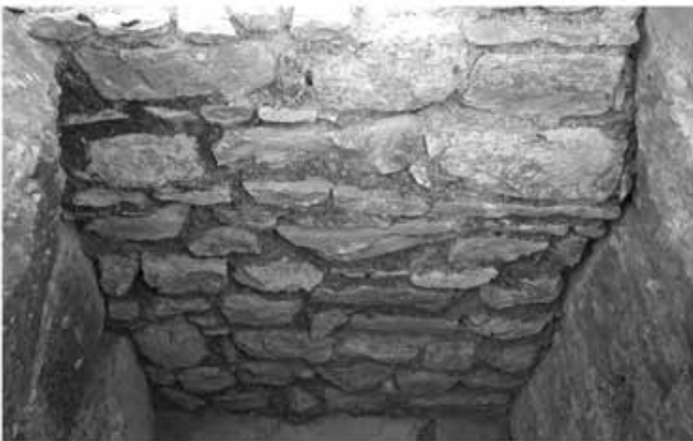
Taf. 20, 2: Interkolumnium 7–8, byz. Abmauerung
