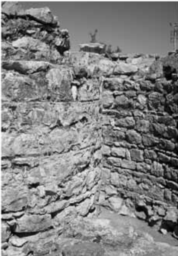
Taf. 24, 3: Mittelpfeiler und Korridor
