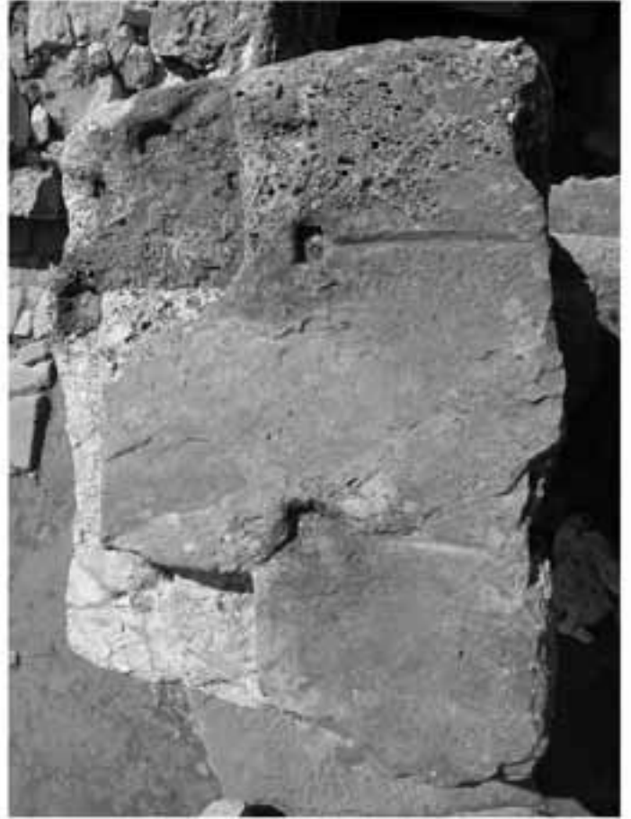
Taf. 16, 4: Pfeiler 11, Draufsicht
