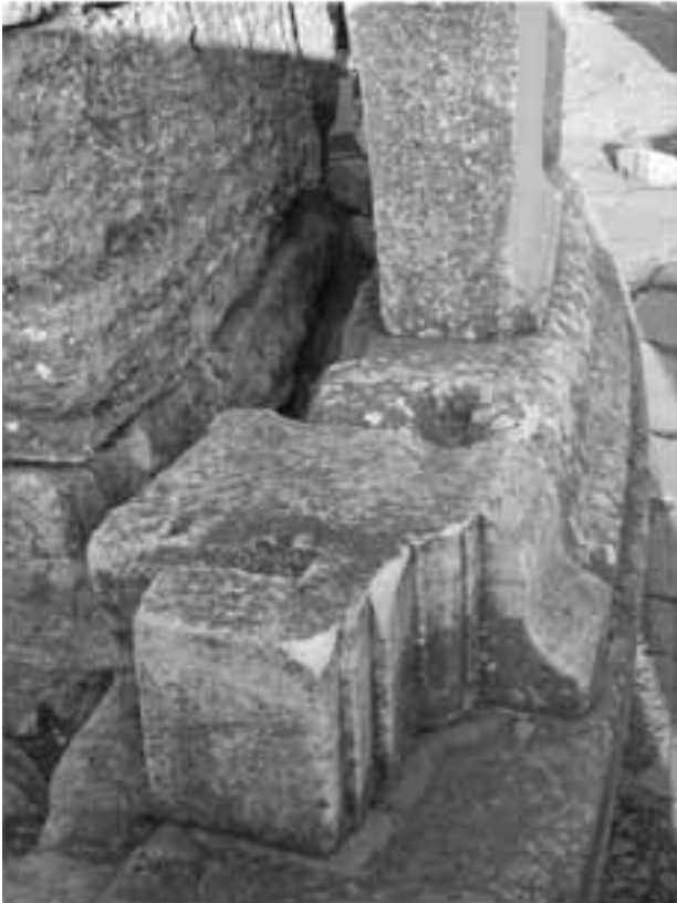
Taf. 18, 1: Fußprofil vor Pfeiler 3
