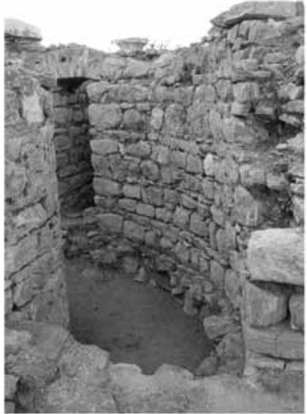
Taf. 25, 2: Korridor, Blick von Osten
