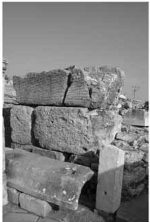
Taf. 15, 3: Pfeiler 12, Außenansicht
