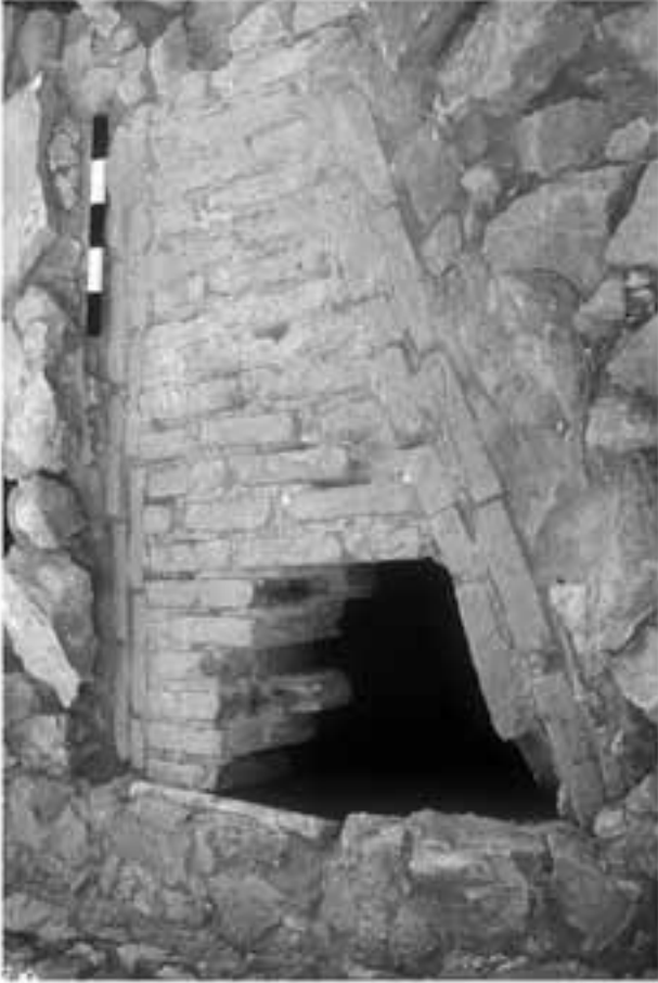
Taf. 22, 2: Kammer 4, Ziegelgewölbe, Außenansicht
