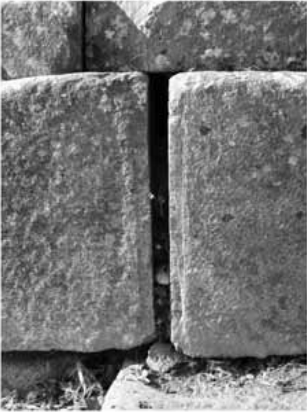
Taf. 17, 1: Stufenschichtblöcke mit Randschlag vor Pfeiler 3
