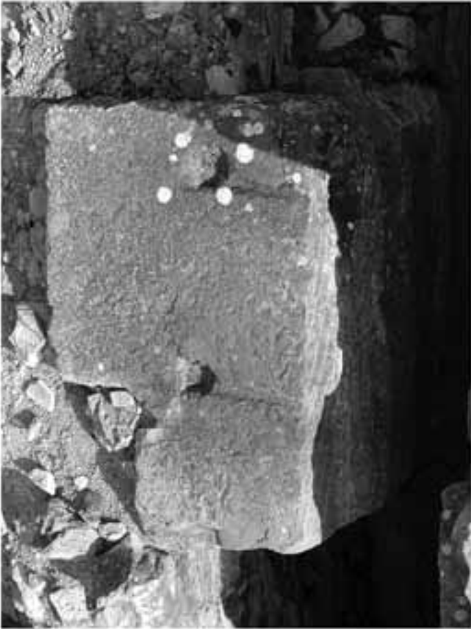
Taf. 16, 1: Pfeiler 7, Draufsicht
