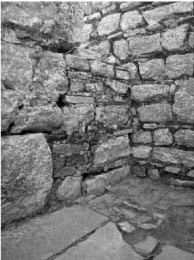
Taf. 13, 3: Pfeiler 4, sekundäre Abmauerung
